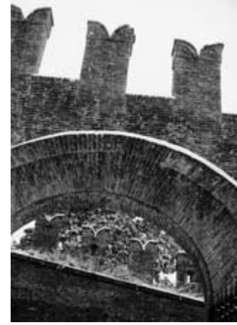
Merli di coronamento di porta Basano nella originaria forma 'a coda di rondine' o 'guelfa'.
